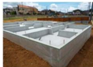
ベタ基礎 底板一面
